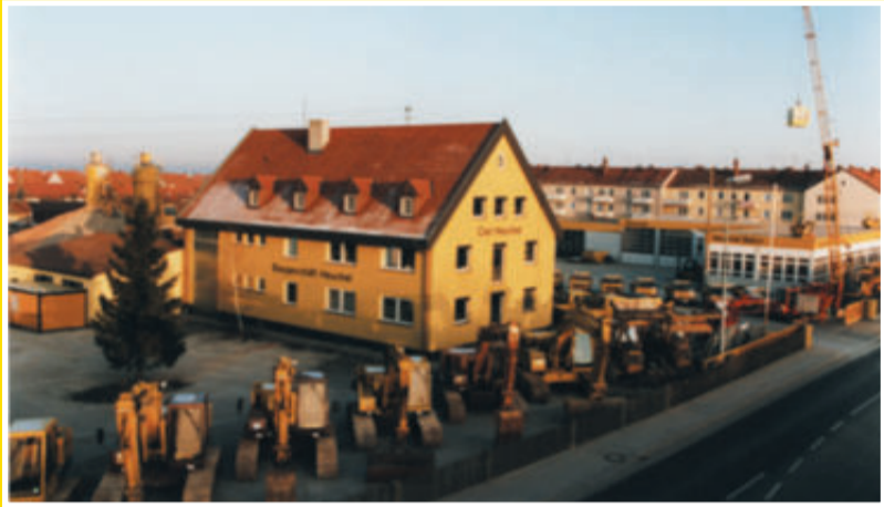
So sah das Gebäude nach dem Umzug an die Augsburger Straße im Jahr 1981 aus.
